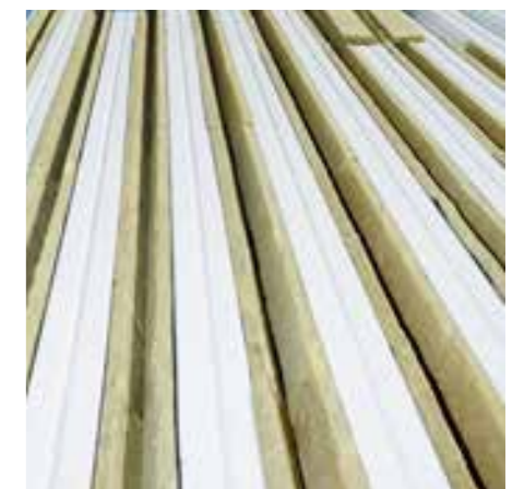
Einlegen von Akustik-Profilfüllern in Trapezprofile
