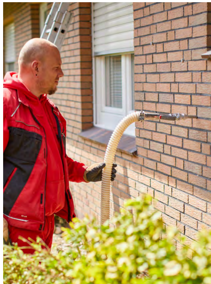
Die Hohlschicht wird nun mit einer oder mehreren Einblasma­schinen mit den passenden Düsen befüllt.
