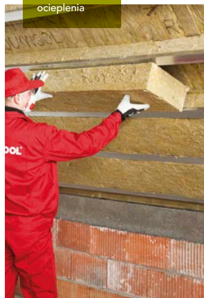
Układanie drugiej warstwy ocieplenia
