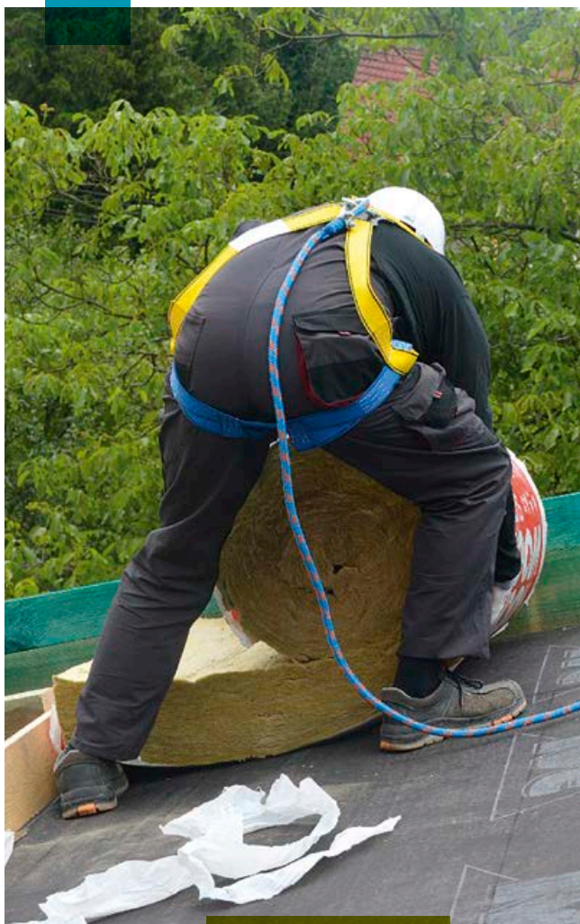
Układanie pierwszej warstwy izolacji
