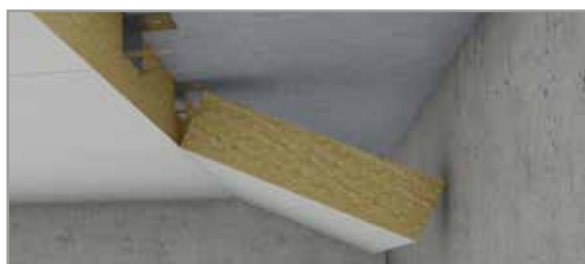
Fase 8: Fissaggio dell'ultima fila di pannelli.
