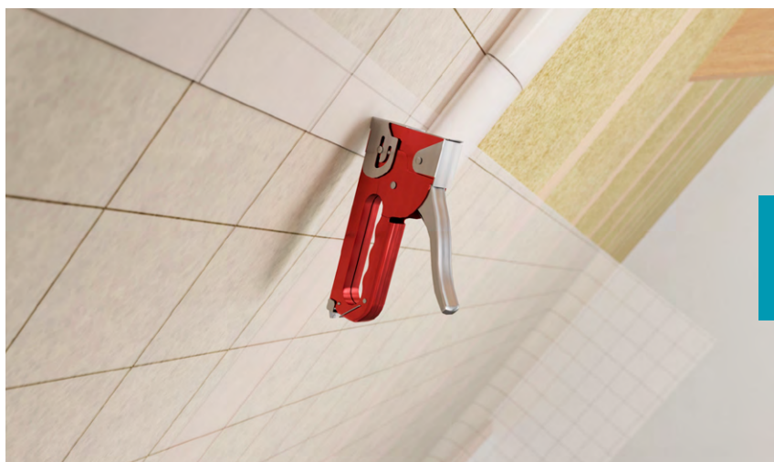
Postavljanje parne brane na drvenu strukturu klamanjem
