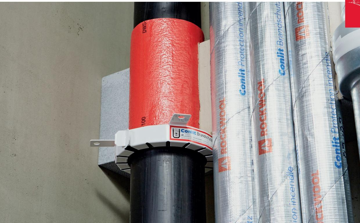
Die Conlit Brandschutzmanschette besteht aus dem Brandschutzmanschettengehäuse, das im Inneren in mehreren Lagen mit einem hochwirksamen intumeszierenden Baustoff ausgestattet ist. Dieser vergrößert durch die Hitze im Brandfall sein Volumen um ein Vielfaches und verschließt so die Bauteilöffnung sicher gegen Durchtritt von Feuer und Rauch.
