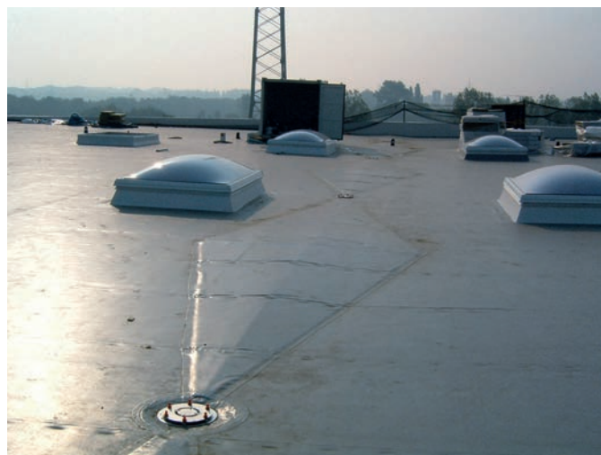
Dubbelzijdig afschot (ROCKWOOL Gootlijnafschot 303)
