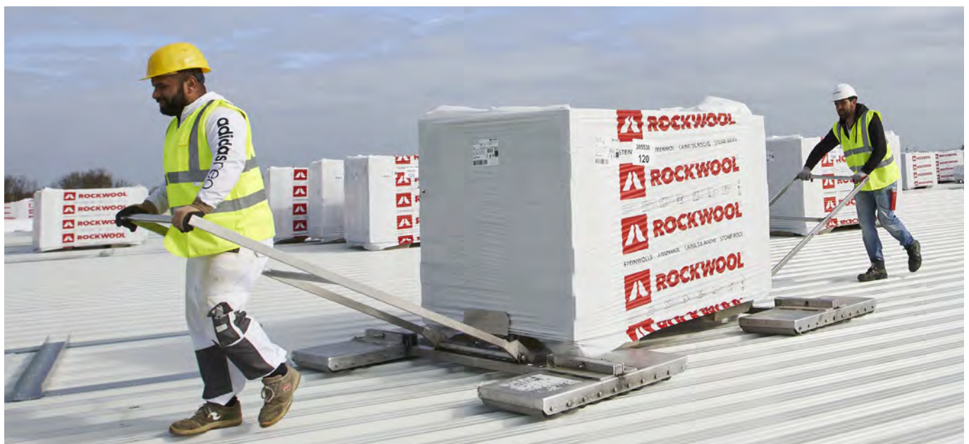
Für den einfachen und sicheren Transport von Großgebinden auf Trapezprofilen bietet ROCKWOOL das Transportgerät Lift and Roller an.
