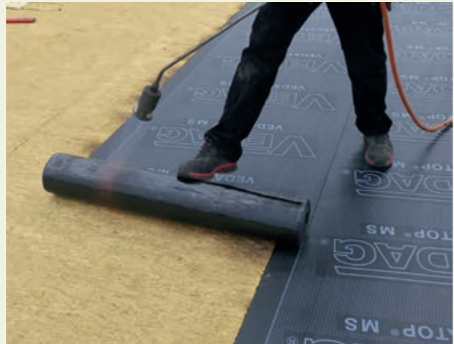
Flamme direkt auf die Bitumenbahn halten
