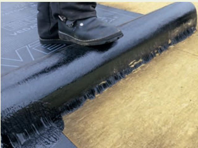
Regelmäßige Haftkontrolle durch Zurückziehen der aufgeschweißten Bitumenbahn
