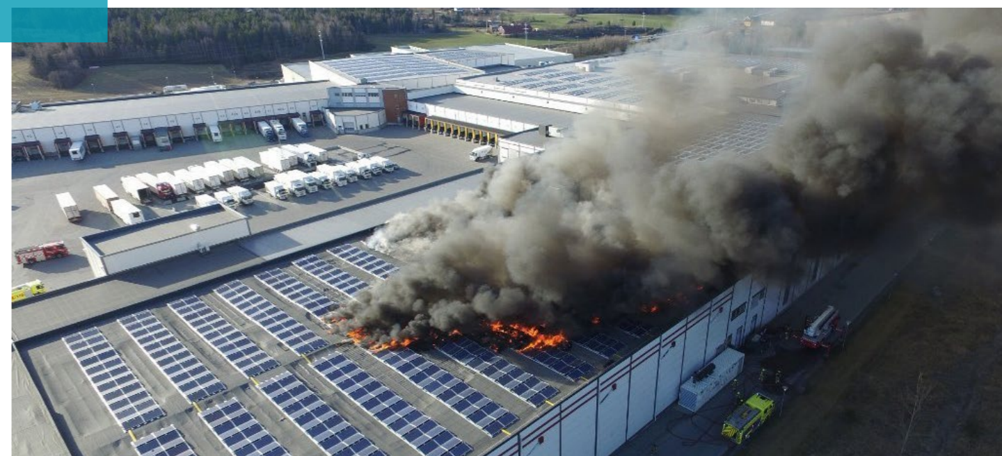
Ubrennbare konstruksjoner bidrar til å begrense den vertikale brannspredningen.
