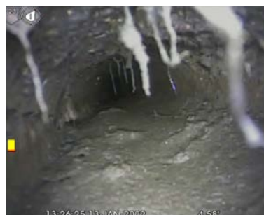
Figuur 8: Voorbeeld van sedimentlaag >2cm
