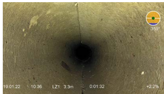
Figuur 6: Voorbeeld van een schoon kanaal
