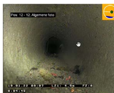
Figuur 7: Voorbeeld van een normale sedimentlaag <2cm
