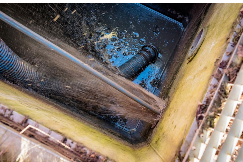
Links: Sedimente werden aus den wasserführenden Kanälen gespült. Rechts: Eine rückwärts sprühende Hochdruckdüse.
