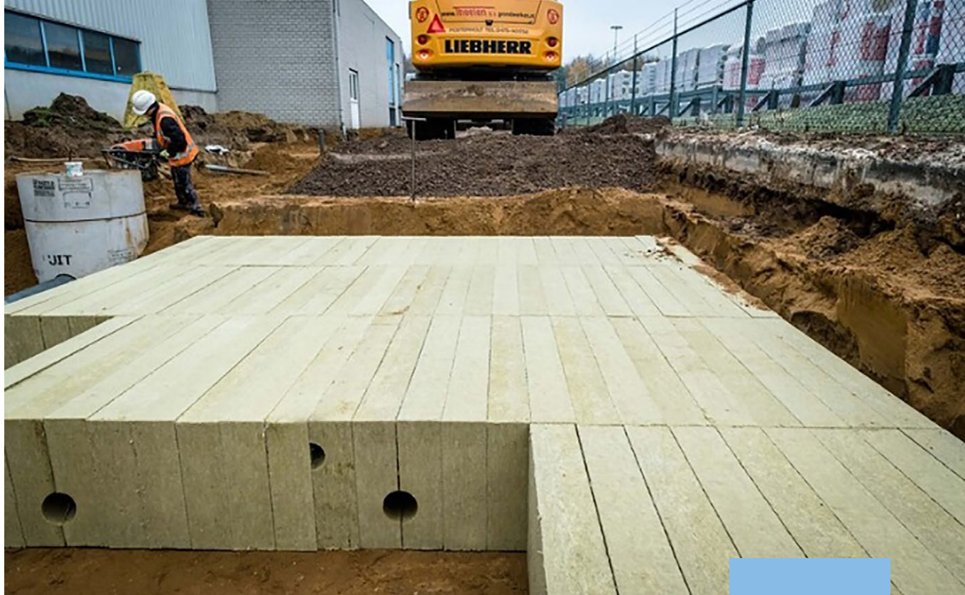
Steenwol heeft een groot infiltratieoppervlak.
