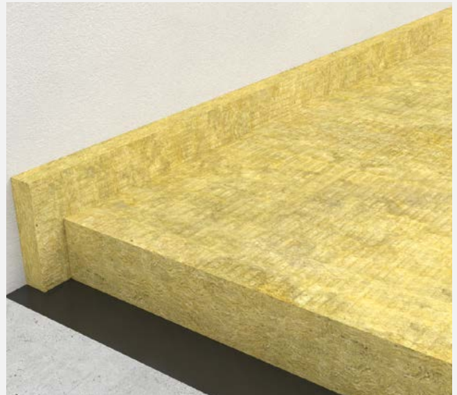
Układanie płyty STEPROCK BASE oraz paska RST.
