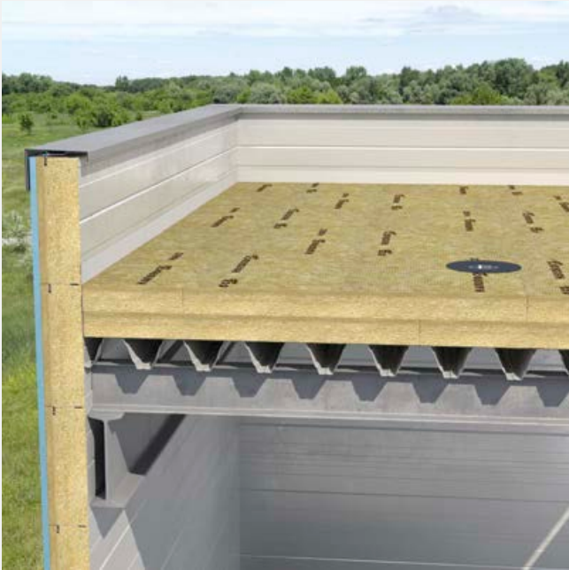
Układanie drugiej warstwy z płyt HARDROCK MAX.
