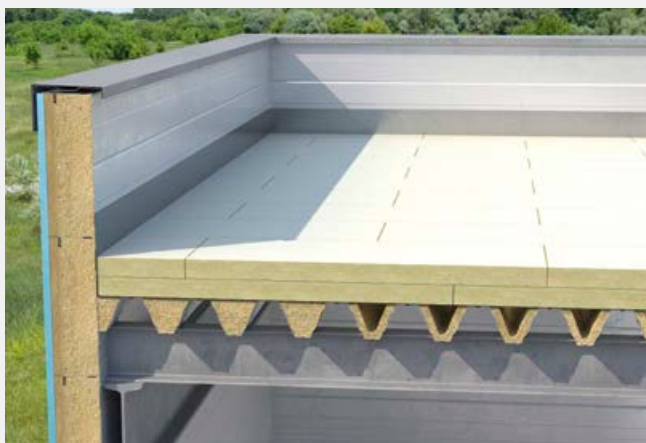
Przyklejenie drugiej warstwy płyt HARDROCK MF PLUS.
