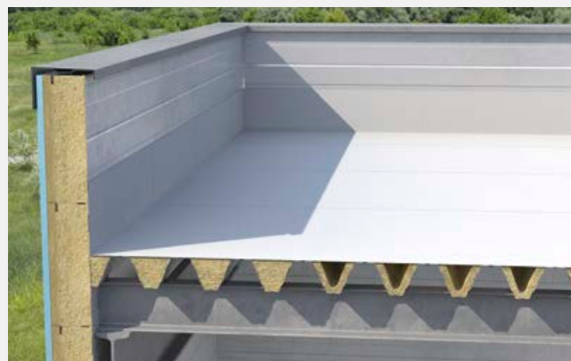
Układanie folii paroizolacyjnej PE.
