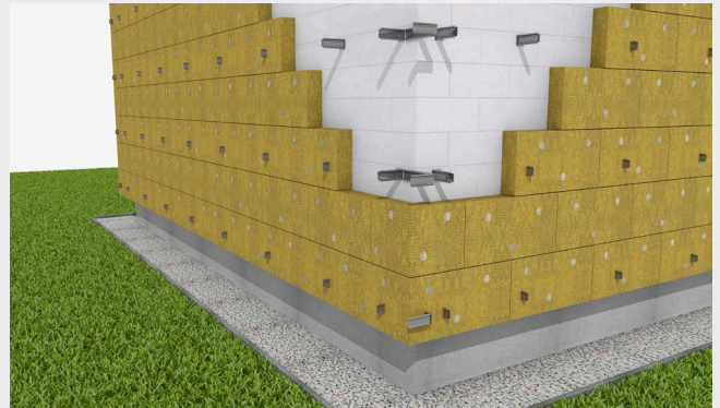
Ułożenie i zakołkowanie wełny do ściany.
