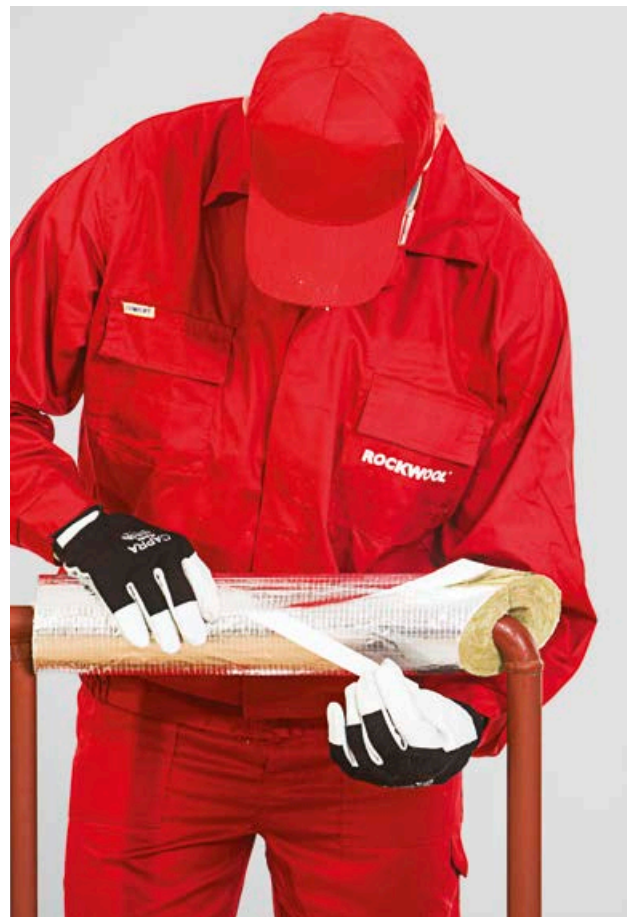
4. Išilginės kevalo įpjovos užklėjimas lipnia užlaida
