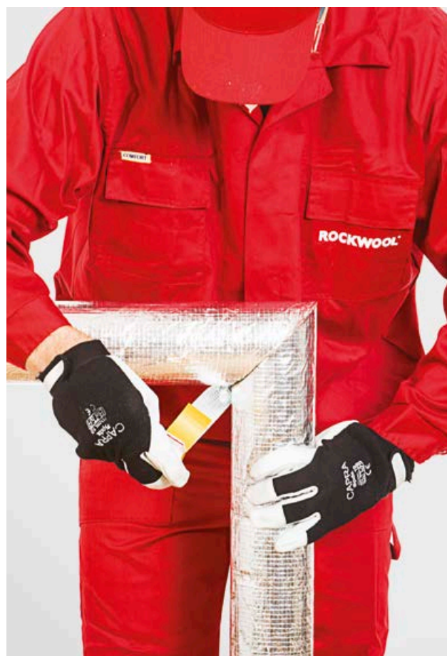
6. Skersinių kevalų sujungimo (sandūros) kljėjimas lipnia aliuminio juosta
