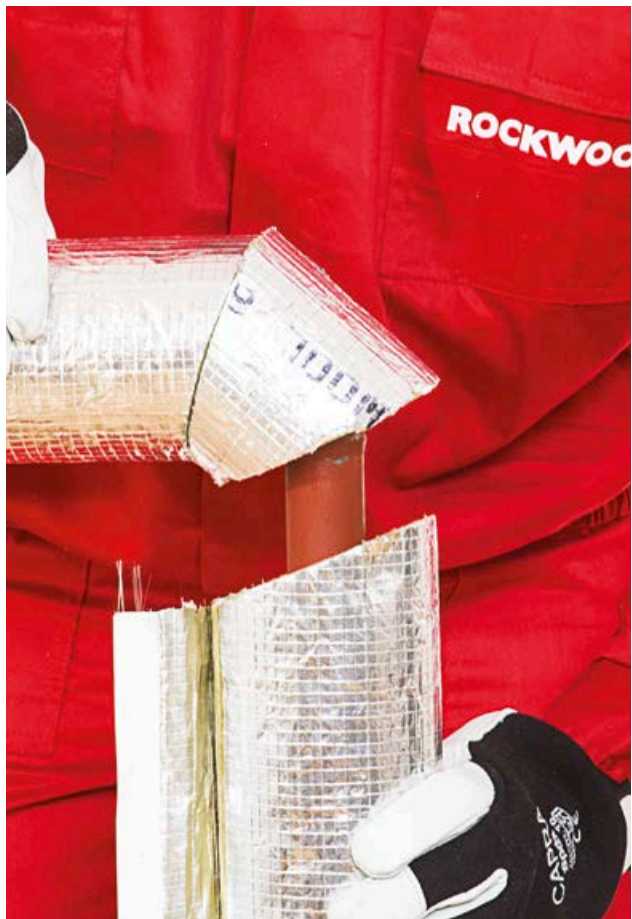
5. Tiesiosios izoliacijos dalies montavimas
