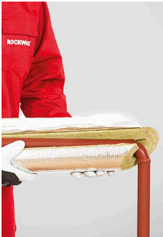
3. Pirmosios izoliacijos dalies uždėjimas ant vamzdžio
