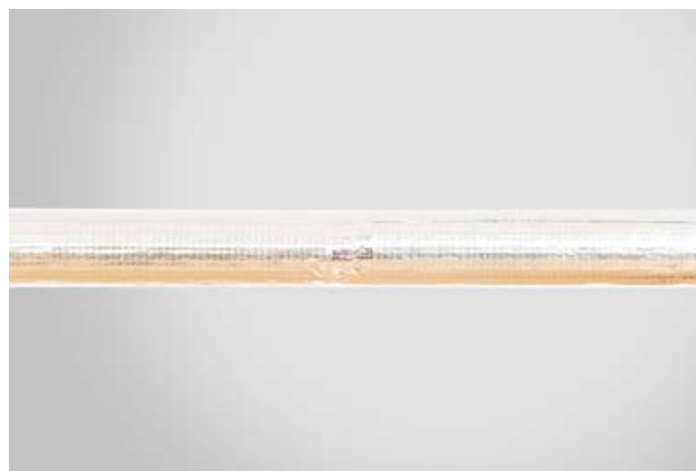
8. Paruošta izoliacija iš dviejų HEATROCK PS kevalų
