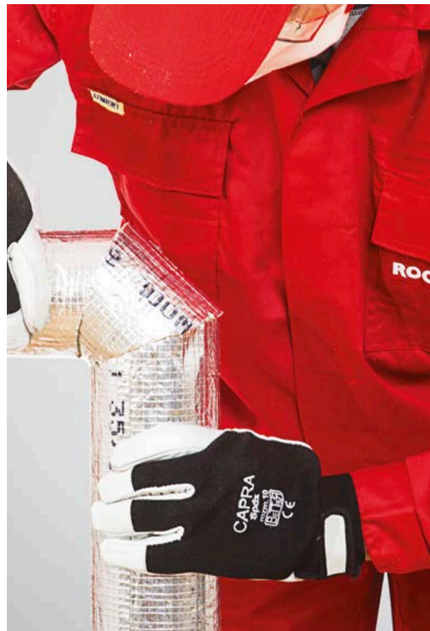
6. Visų dalių tikslus sujungimas
