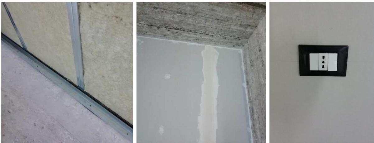
Figura 6\_ Fasi della costruzione
