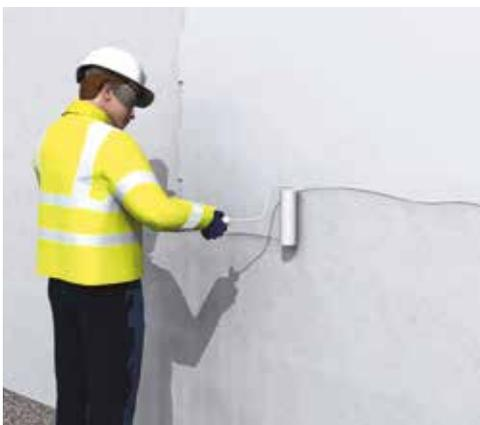
*Figura 18 - Applicazione del fissativo (primer) sulla rasatura armata*
