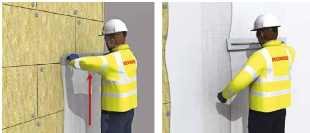
Figura 17 - Realizzazione della rasatura armata
