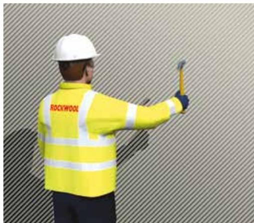
Figura 10 - Verifica della compattezza del supporto mediante piccozzatura
