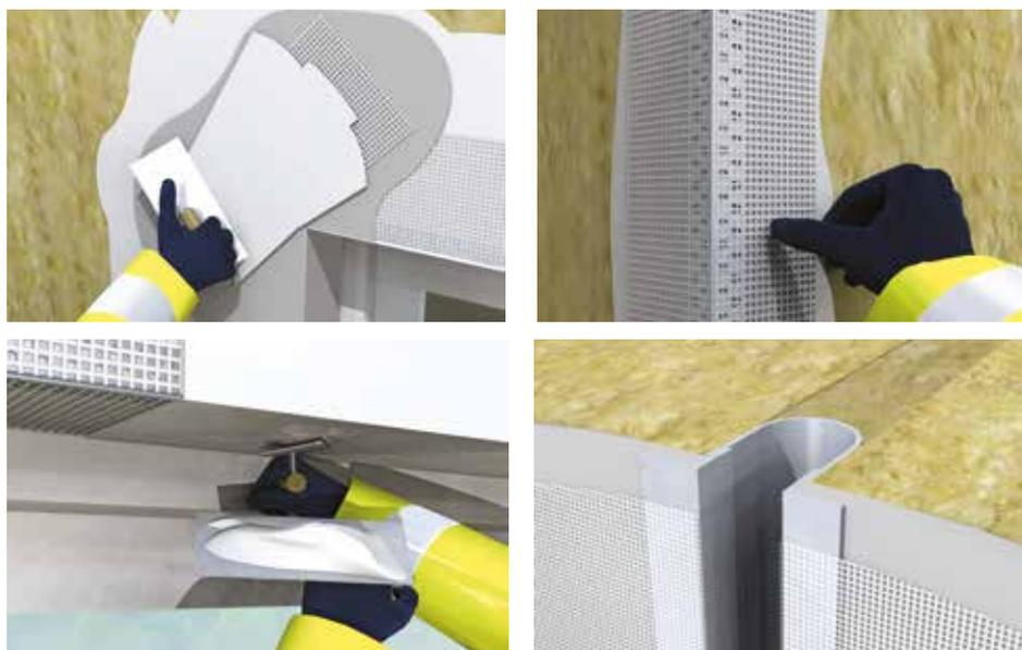
Figura 16 - Esempi di posa di profili e rinforzi dei punti singolari del sistema a cappotto
