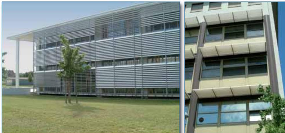
Figura 2.14 Esempi di protezioni solari verticali mobili (a sinistra) e di oggetti orizzontali (a destra)
