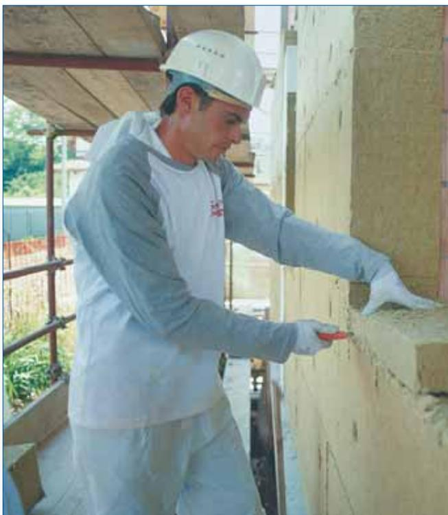
Attenzione va posta nel posizionamento del materiale isolante: una soluzione "a cappotto" permette di ridurre i ponti termici e di poter sfruttare l'inerzia termica della parete. Collocandolo in intercapedine invece è possibile non influenzare eccessivamente eventuali esigenze estetiche.
