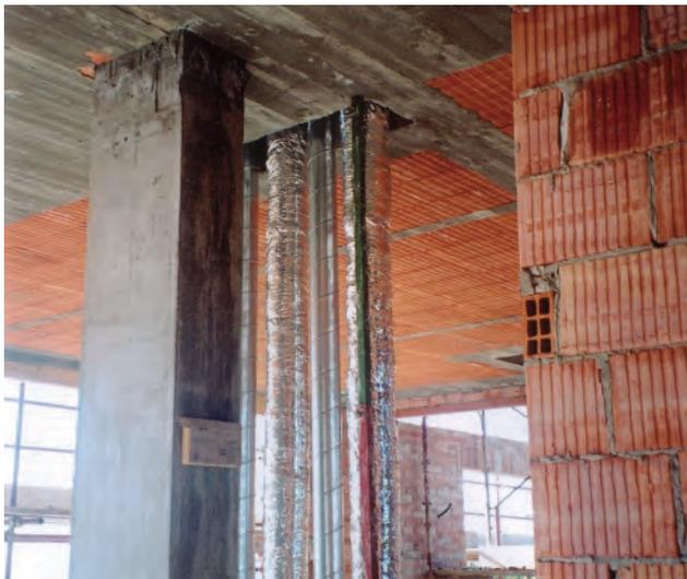
Cavedi (piano terra) con condotte dell'aria proveniente dalla pompa di calore posta al piano interrato.
