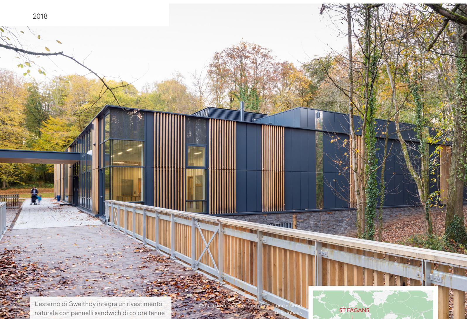
L'esterno di Gweithdy integra un rivestimento naturale con pannelli sandwich di colore tenue
