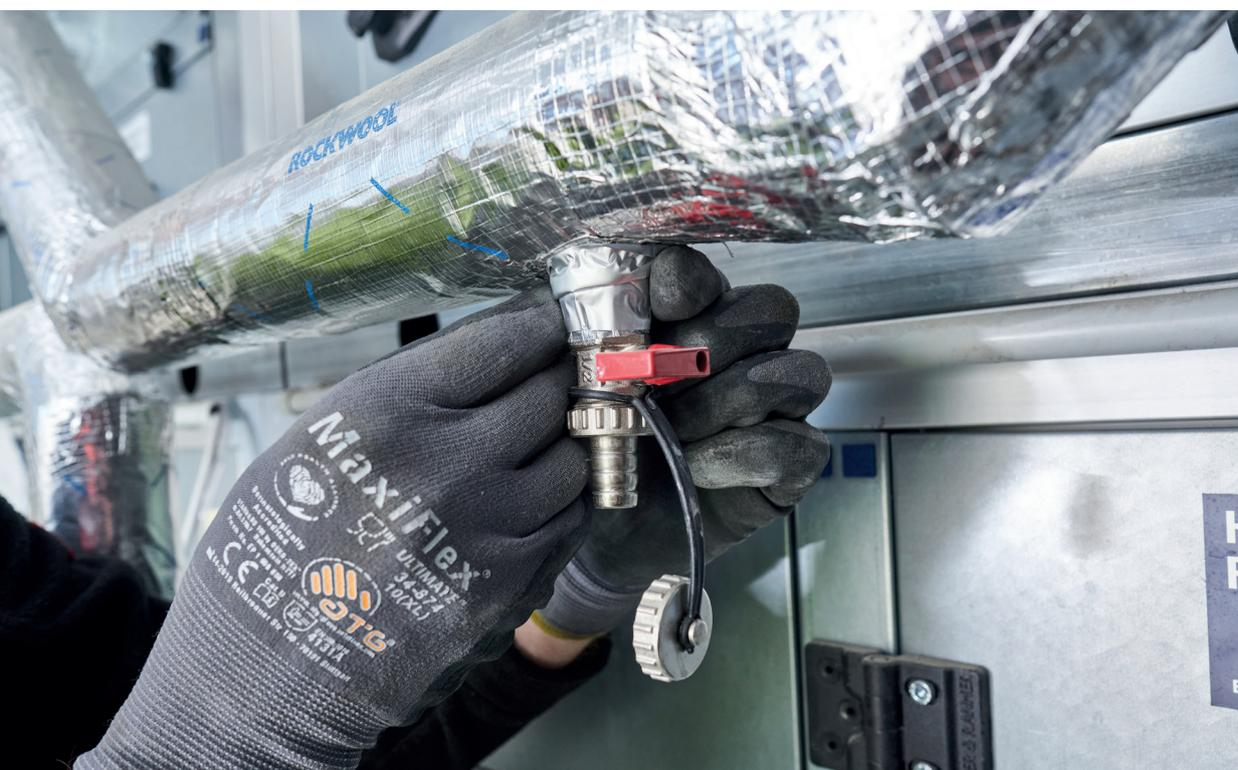
Das ROCKWOOL Teclit Flextape ist ein hochwertiges Dichtband für die Verklebung von Dämmstoffstoßstellen, die hohe Flexibilität und Festigkeit aufweisen müssen. Es besitzt eine sehr hohe Haftfähigkeit und ist sehr flexibel. Damit eignet es sich besonders für die Abdichtung von Verbindungen und Durchdringungen von Kälte-dämmungen an haustechnischen Anlagen mit dem Teclit System.
