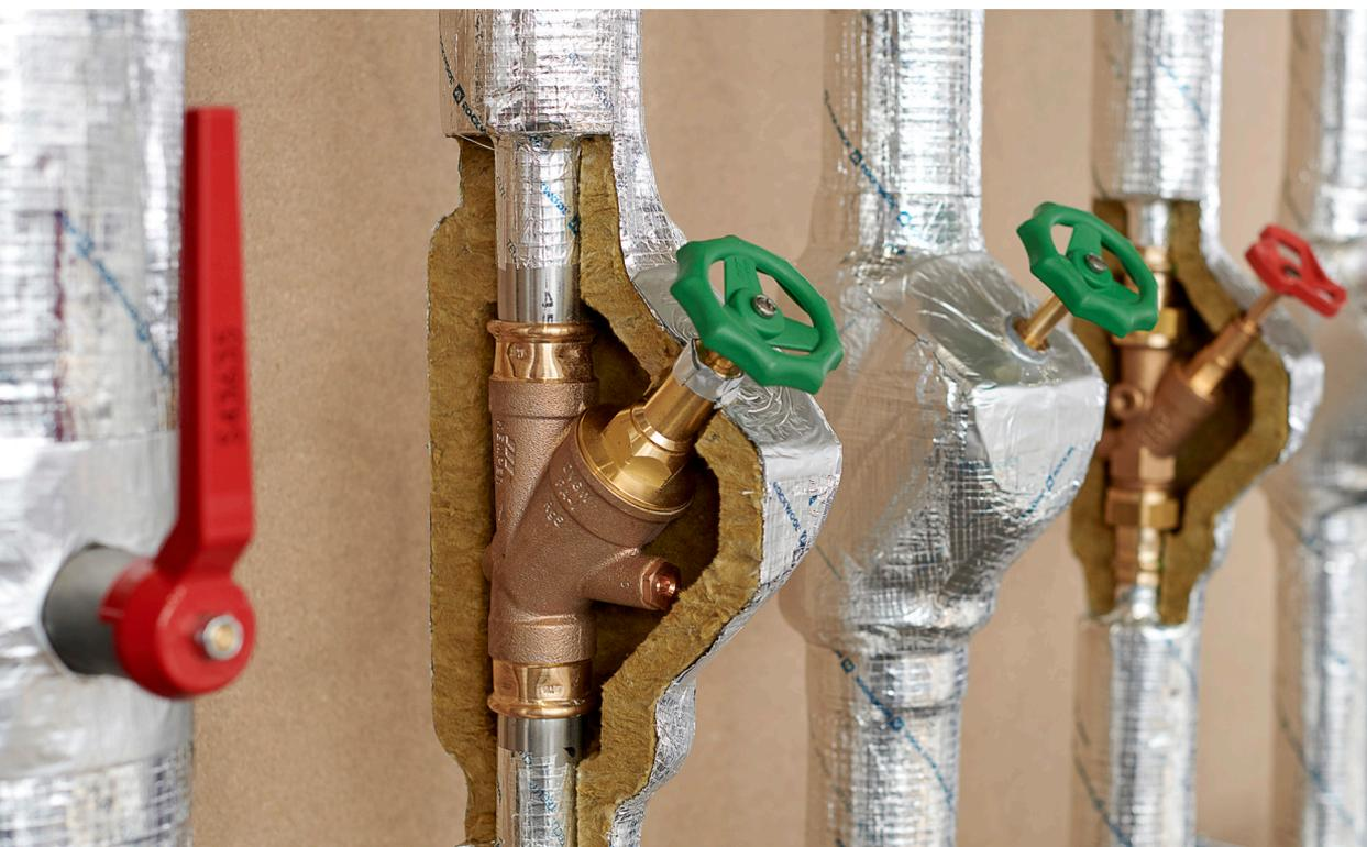
Die Teclit Dämmkappe ist ein hochwertiges Steinwolle-Formteil zur einfachen und sicheren Dämmung von Ventilen in haustechnischen Anlagen. Ihre Bauform wurde so entwickelt, dass sie auf eine Vielzahl marktgängiger Ventilformen passt. Sie ist mit einer besonders hochfesten glasfaserverstärkten Aluminiumfolie ummantelt und eignet sich damit besonders zur Anwendung innerhalb des nichtbrennbaren Teclit Kälte­dämmsystems.
