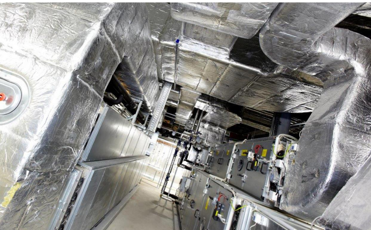
Die ROCKWOOL Klimarock weist aufgrund ihrer überwiegend senkrecht zur Mattenebene ausgerichteten Mineralwolle-Struktur eine hohe Flexibilität bei gleichzeitiger Druckfestigkeit auf. Sie ist einseitig mit einer gitternetzverstärkten Aluminiumfolie kaschiert.
