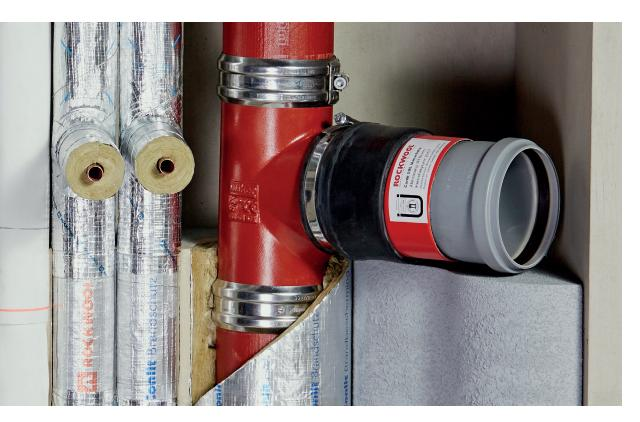
Das Set besteht aus der Conlit Muffenrohrschale S zum Einbau in die Deckendurchführung und aus der Conlit SML-Manschette. Die Muffenrohrschale entspricht dabei im Wesentlichen der Conlit 150 U, wurde jedoch in ihrer Länge und Dämmdicke sowie durch eine einseitige Aussparung zur Überdeckung von Rohrmuffen bzw. -schellen dem speziellen Anwendungsbereich angepasst. Die SML-Manschette besteht aus einer Blechhülse mit mehreren Lagen intumeszierendem Material.
