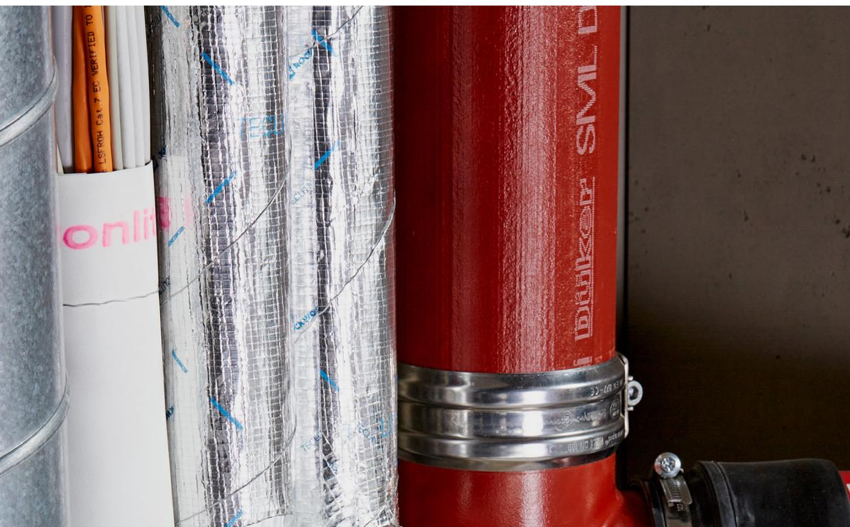
Die Conlit Bandage ist eine ca. 1 mm dicke flexible Matte, die aus einem Trägergewebe besteht, das beidseitig mit einem unter Hitzeeinwirkung aufschäumenden Material beschichtet ist. Sie wird im Conlit Abschottungssystem für Elektroleitungen und Elektroerohre verwendet.
