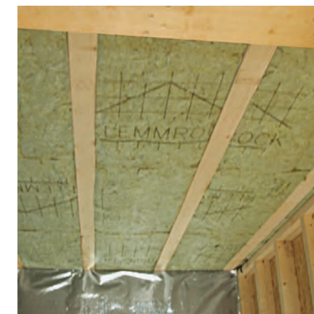
Effiziente und schnelle Dämmung der Holzbalkendecke mit nichtbrennbarer Steinwolle von der Rolle: Klemmrock 035
