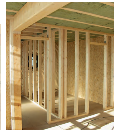
Das vorgefertigte Rahmenwerk einer Innenwand wird erst auf der Baustelle gedämmt und beplankt.
