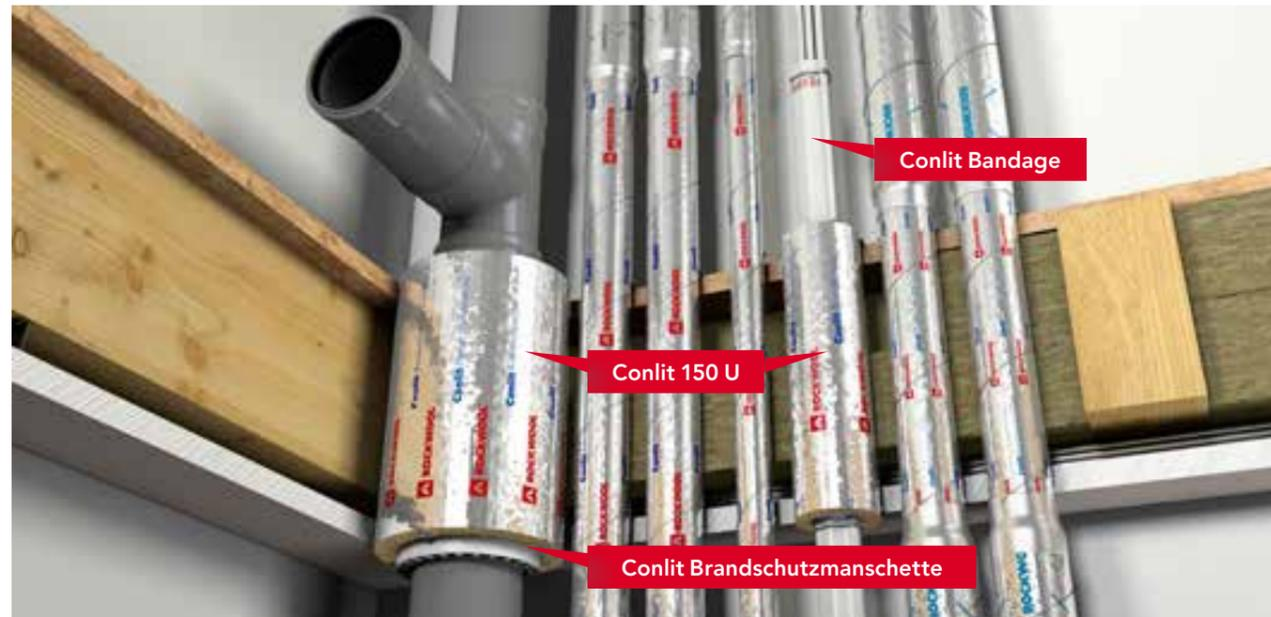
Die Conlit 150 U Schalen werden wie gewohnt zur Ummantelung von Rohrleitungen in passgenaue Kernbohrungen eingesetzt.
