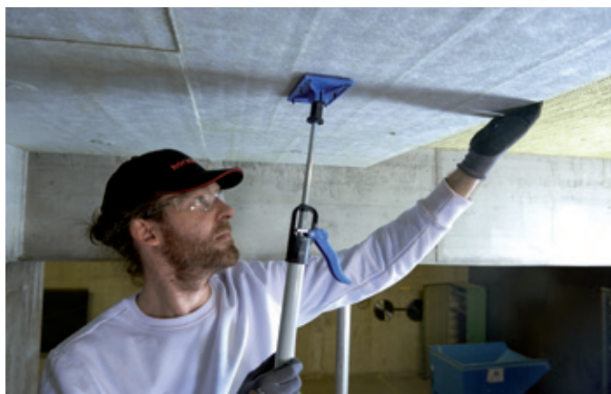
Étape 1 : excellentes propriétés antifeu grâce à Conlit Steelprotect Board
