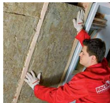
практически в любой автомобиль (есть упаковки двух размеров). Этот долговечный, простой в монтаже, устойчивый к воздействию влаги и перепадам температур утеплитель обеспечивает также и пожарную безопасность. Он плотно примыкает к конструкции без образования щелей, поэтому в доме сохраняется комфортная температура и нет сквозняков. ЛАЙТ БАТТС СКАНДИК подойдет для утепления кровли, чердака и мансардных помещений, перегородок, междуэтажных перекрытий, стен дома и подвальных помещений.
