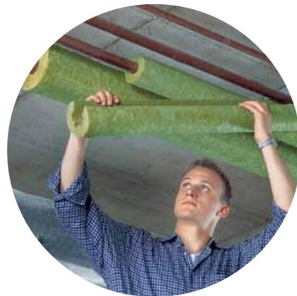
Существует два способа производства цилиндров из каменной ваты: навивной и вырезной. И главное различие между ними становится явным не столько при их производстве или монтаже, сколько во время эксплуатации. Речь идет о такой характеристике, как теплопроводность, и связанных с ней тепловых потерях.
