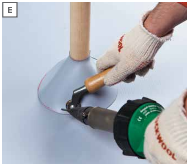
Е. Затем мембрана приваривается внизу к основному кровельному ковру с использованием узкого металлического ролика.
