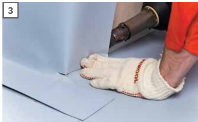
З. Аналогично производится укладка мембраны на других вертикальных поверхностях.
