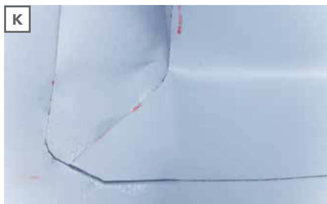
К. Полностью изолированный внешний угол плоской кровли.
