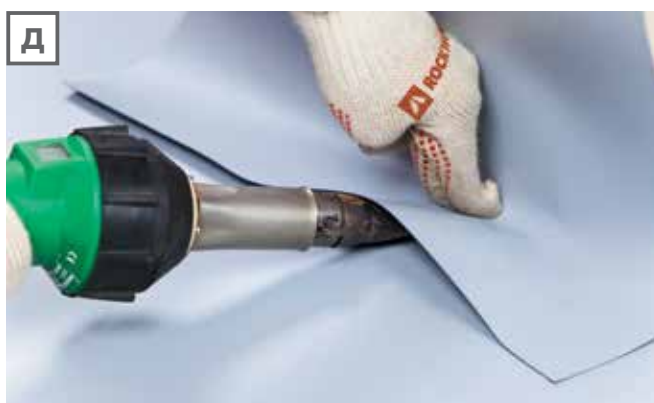
Д. С вертикальной поверхности до этих отметок спускается мембрана.
