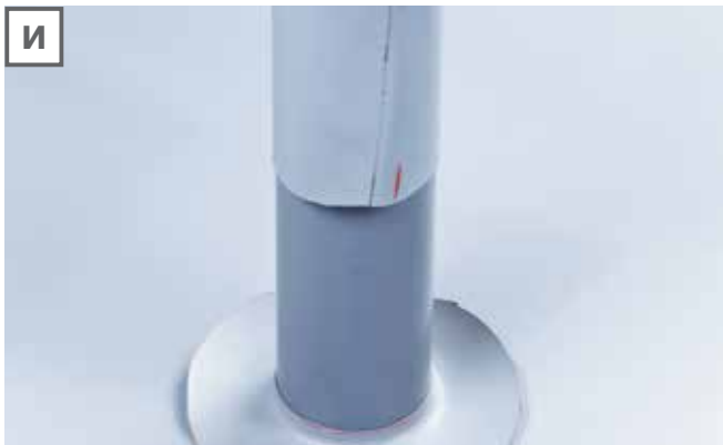
И. После этого подготовленная трубка из мембраны натягивается на изолируемую трубу.
