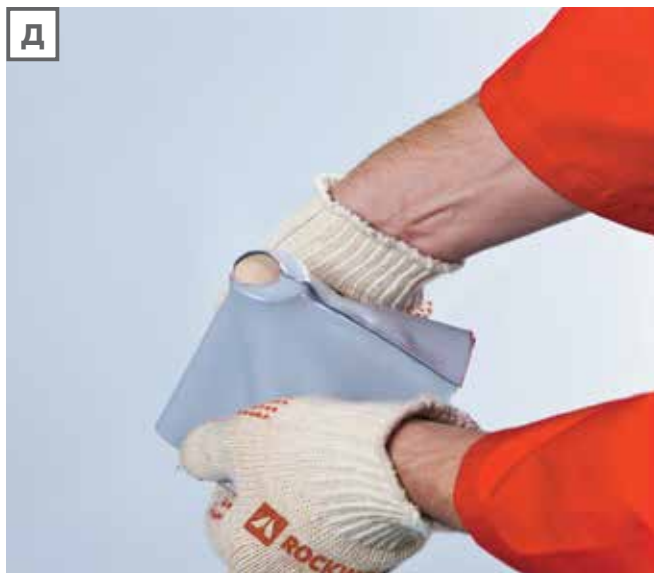
Д. И пока не остыла, мембрана натягивается на изолируемый проход.
