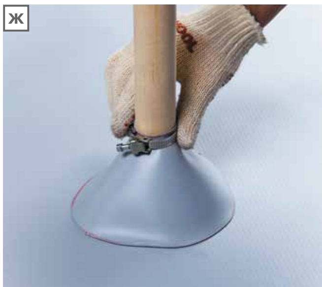
Ж. Верхняя часть трубки обжимается металлическим хомутом и заливается герметиком.
