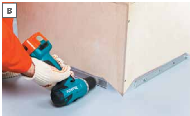
В. Механически закрепляется с помощью специальных шин, изображенных на фото в п. 7.
