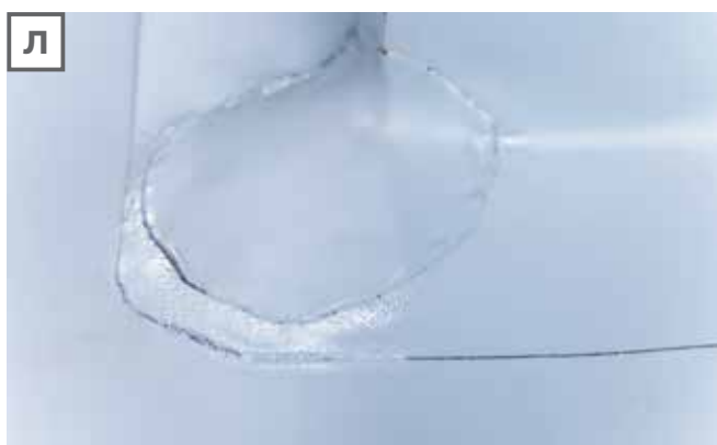
Л. Для надежности герметизации угловой точки «внешнего угла» на поверхности кровли устанавливают накладку внешнего угла.
