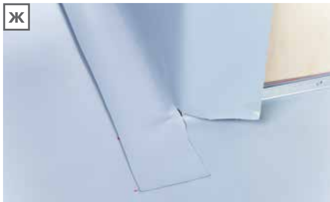
Ж. Затем провариваются вертикальные соединения мембран.
