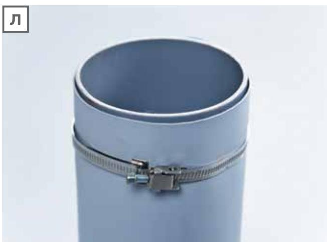
Л. Верхняя часть трубки обжимается металлическим хомутом и заливается герметиком.
