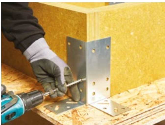
Montering sker med REDAir Link Hörnbeslag och medföljande skruv.
