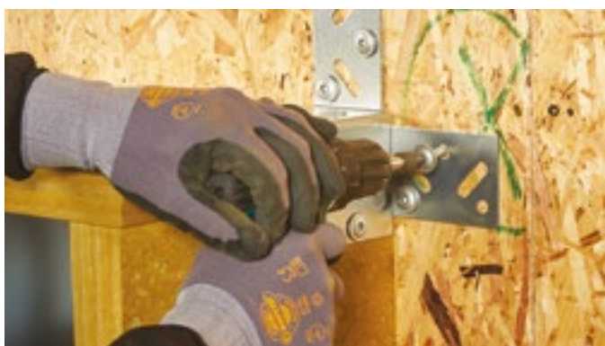
REDAir Link monteras mot väggen med föreskrivna skruvar.
