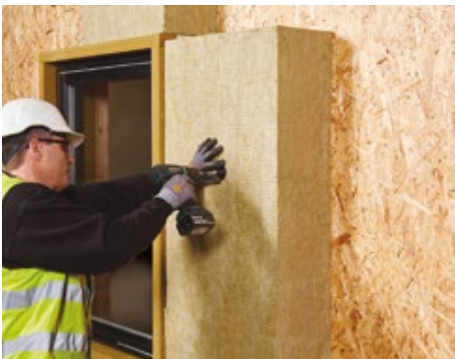
Montering av REDAir System (RedAir Batts) omkring REDAir Link Board.
