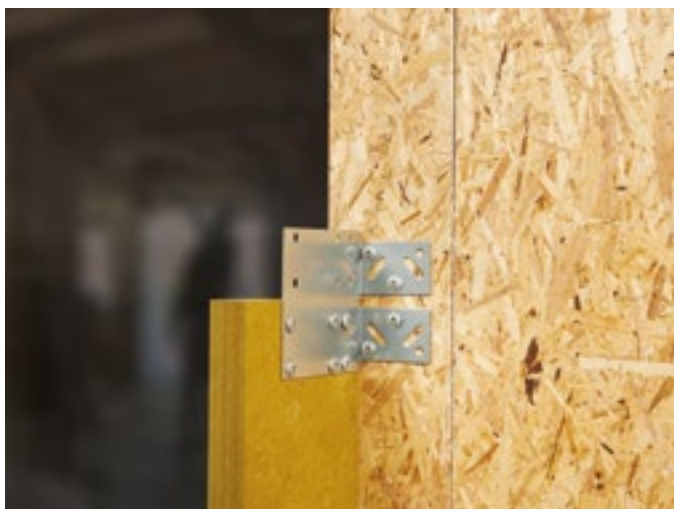
REDAir Link skarvbeslag monteras på väggen.
