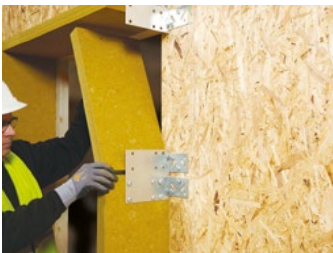
REDAir Link skiva fästs i de förmonterade beslagen.
