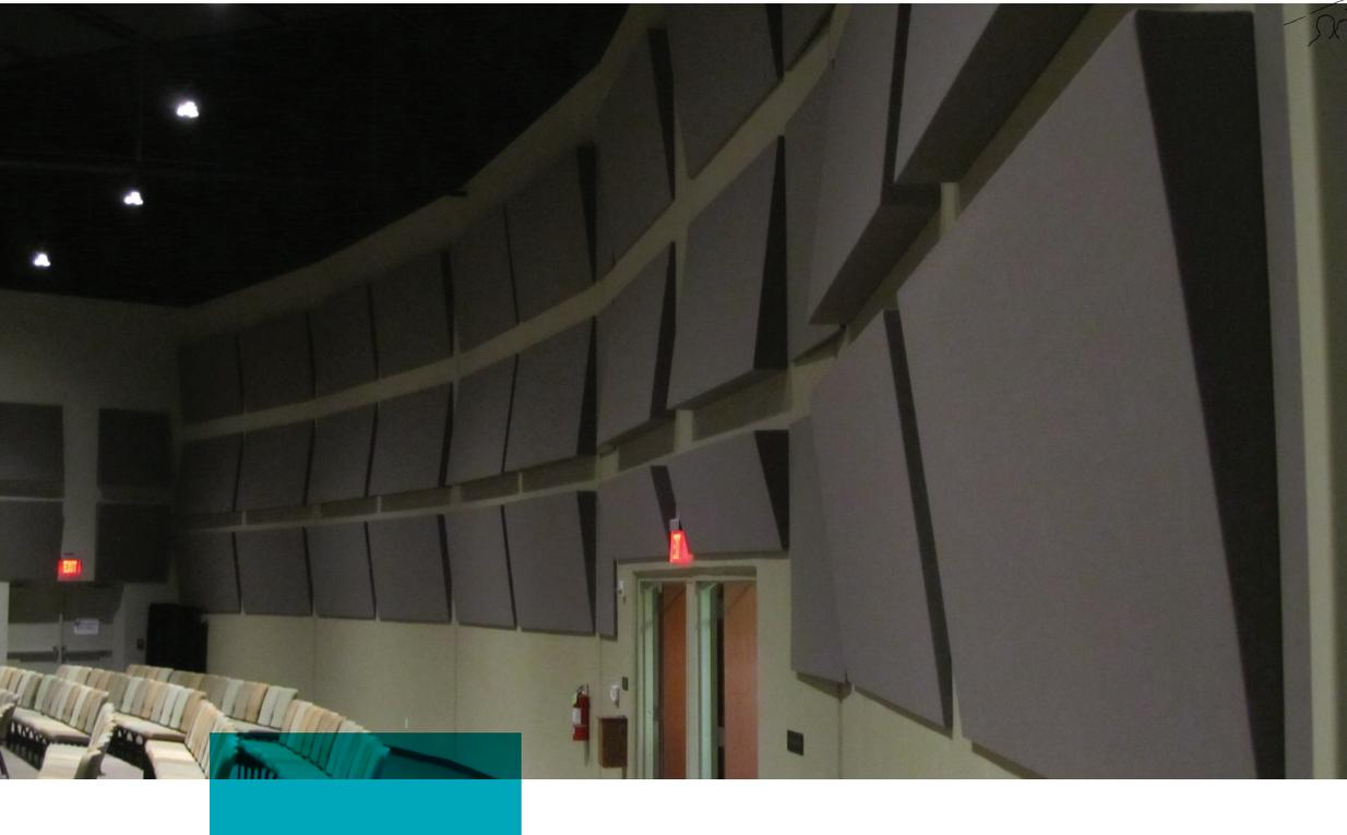
ROCKWOOL Conrock<sup>MD</sup> 60 est un panneau isolant en laine de roche conçu spécifiquement pour les panneaux acoustiques. Nous l'avons créé afin de venir en aide à nos clients FEO qui recherchent une isolation offrant, entre autres choses, d'incroyables propriétés d'atténuation et d'absorption du bruit.
