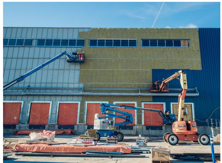
Lorsqu'ils sont exposés à des conditions météorologiques clémentes, les isolants pour murs extérieurs ROCKWOOL non revêtus, lorsqu'ils sont installés verticalement, peuvent demeurer exposés jusqu'à 90 jours sans que cela nuise à leurs propriétés. L'isolant Cavityrock<sup>MD</sup> Black, qui est doté d'un revêtement, peut être exposé jusqu'à 30 jours sans subir d'effets néfastes.
