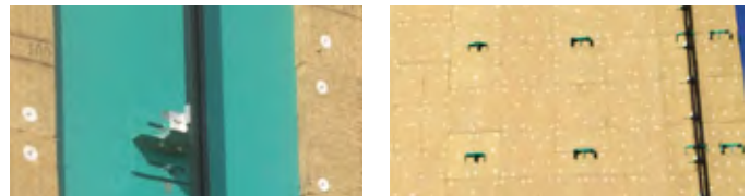
Ejemplo de ancla de diseño técnico para trabajo pesado que consta de placas de acero grandes soldadas y sistema de rieles verticales.
