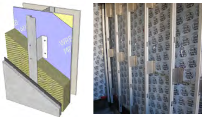
Clips de acero inoxidable intermitentes con perfiles verticales.
