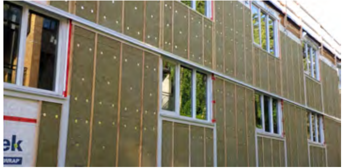
Ejemplo de aislante sostenido por pasadores para aislante fijados mecánicamente entre el marco de madera vertical (los pasadores adhesivos no se consideran una estrategia de soporte a largo plazo).
