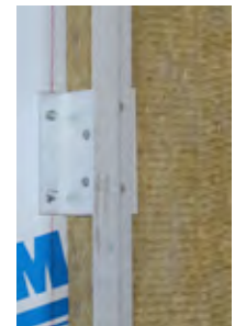
Clips de ángulo en L genéricos ajustables adosados uno contra otro.
