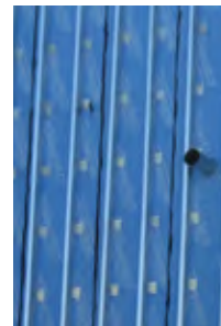
Clips de acero galvanizado intermitentes con perfiles verticales.
