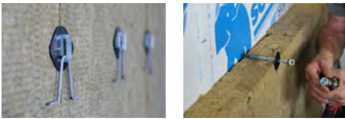
Ejemplos de amarres a mampostería instalados a través del aislante CAVITYROCK® de ROCKWOOL.
