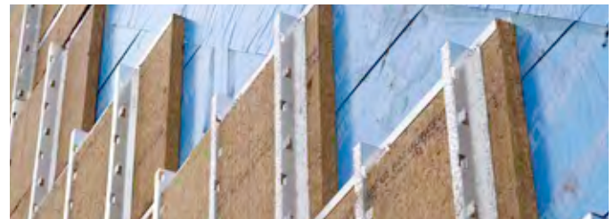
Sistema de soporte del revestimiento de perfiles transversales en Z con perfiles verticales en Z perforados a la medida, utilizados para retener el aislante CAVITYROCK® de ROCKWOOL.
