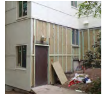
Tornillos largos a través de armadura vertical de madera y aislante rígido COMFORTBOARD™ de ROCKWOOL en un proyecto residencial multifamiliar.
