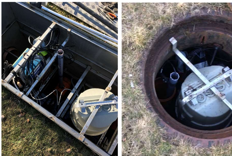
Figur 1.3. Placering af prøvetagning- og måleudstyr i indløbsmanifold (tv.) og udløbsbrønd (th.)
