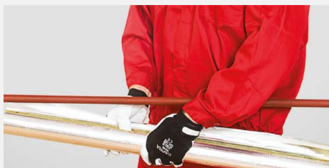
Nałożenie otuliny na odcinek prosty rurociągu.
