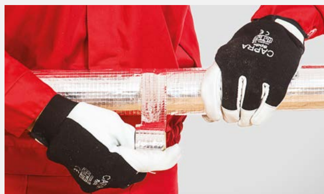
Zabezpieczenie połączenia poprzecznego otulin samoprzylepną taśmą aluminium.
