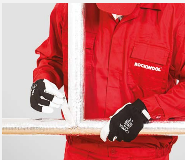
Sklejenie styków izolacji taśmą aluminiową.
