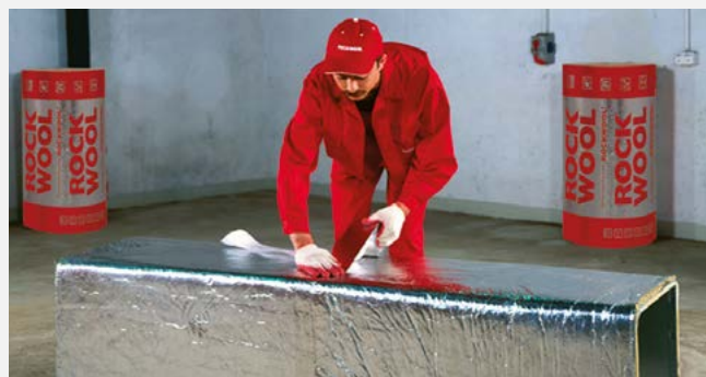
Krok 4 – uszczelnienie taśmą aluminiową połączeń podłużnych i poprzecznych maty.
