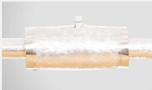
Gotowa izolacja zaworu przy użyciu KLIMAMAT.
