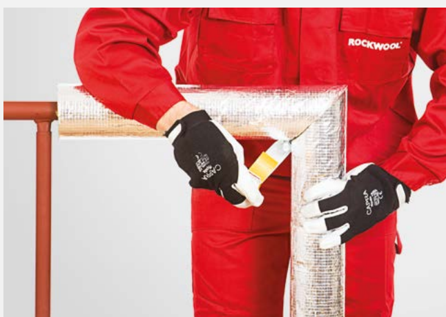
Zabezpieczenie połączenia poprzecznego otuliny samoprzylepną taśmą aluminiową.
