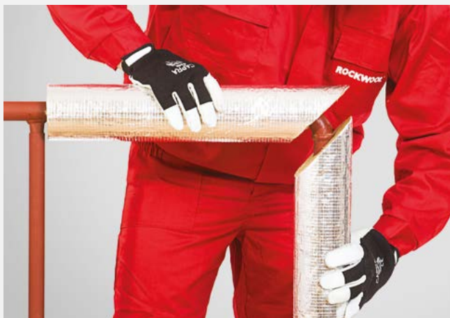
Dopasowanie obu elementów izolacji kolana.
