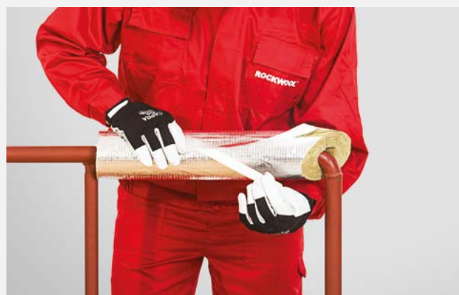
Sklejenie połączenia wzdłużnego zakładką samoprzylepną.
