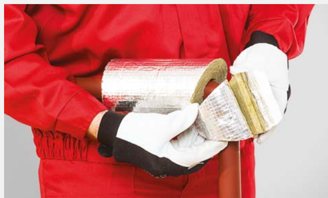
Montaż jednego segmentu kolanowego.
