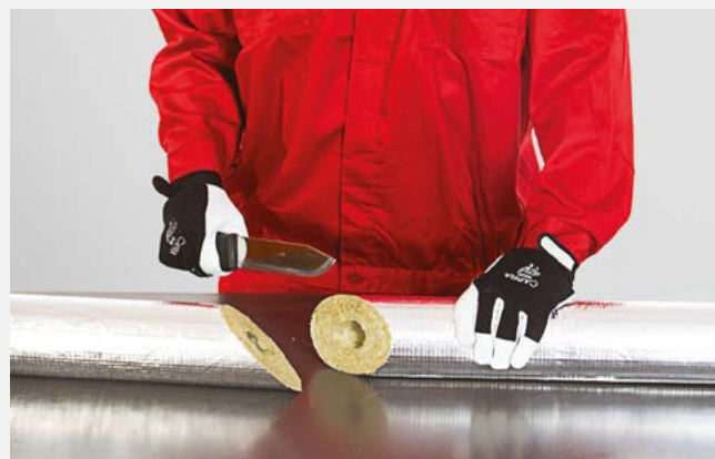
Rozcięcie otuliny pod kątem 45° na dwa elementy.
