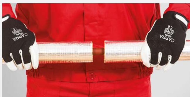
Połączenie poprzeczne dwóch odcinków otulin.
