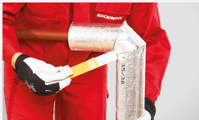
Sklejenie połączeń poprzecznych taśmą aluminiową.
