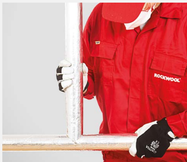
Dopasowanie łączonych odcinków.
