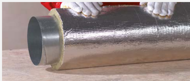
Krok 2 – owinięcie kanału izolacją.
