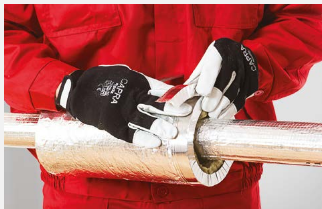
Zabezpieczenie zakończenia izolacji mankietem aluminiowym.
