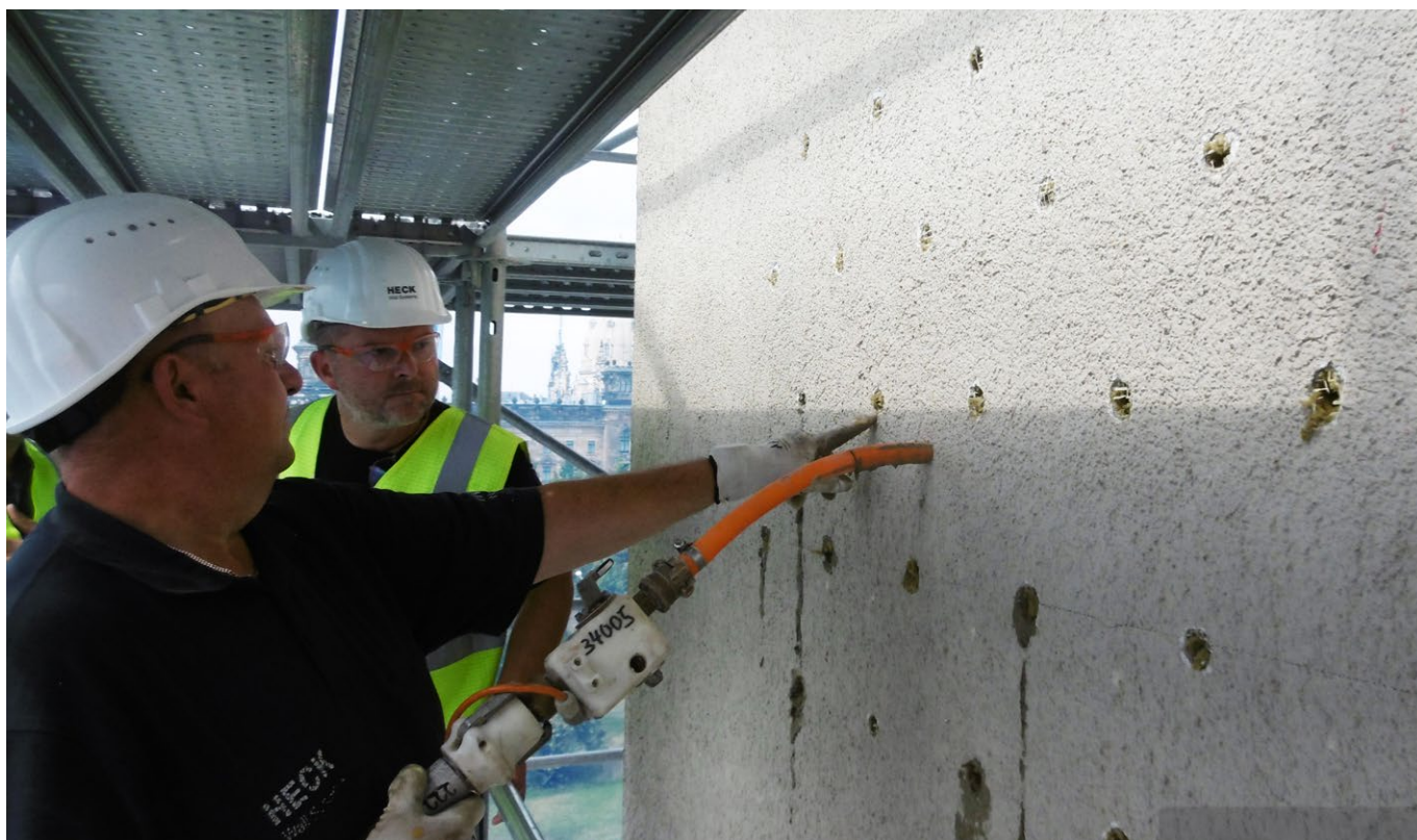
Prima di applicare l'isolamento esterno ROCKWOOL, gli operai hanno aggiunto della malta dietro al vecchio strato di isolamento in lana minerale della facciata.
