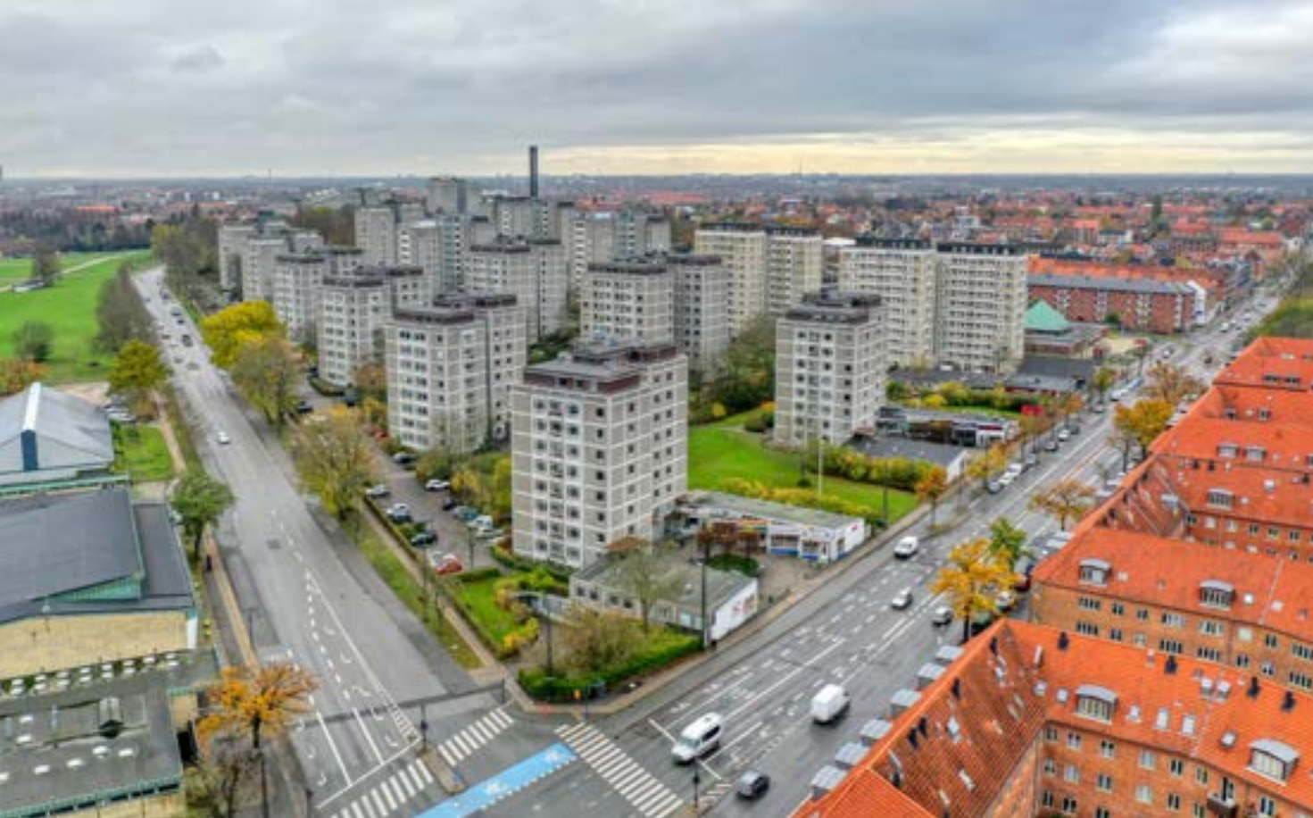
La rénovation préservant l'héritage est l'objectif des Bellahøj Houses, les premiers gratte-ciels du Danemark.
