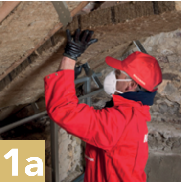
Pose de la 1 ère couche d’isolant Rockcomble entre les chevrons.
