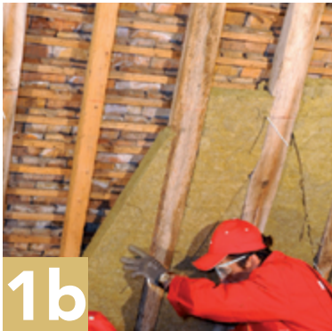
Ou bien pose de la 1 ère couche d’isolant Deltarock entre les chevrons.
