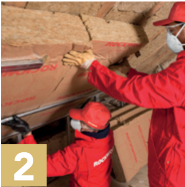
Pose de la 2 ème couche Rockckomble derrière l’ossature métallique.
