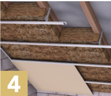
Mise en œuvre de l'ossature secondaire et de la finition. Pour en savoir plus sur la pose de Rockcomble Evolution : www.rockwool.fr
