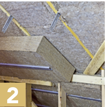
Pose de la 2 ème couche Rockplus Premium derrière l'ossature métallique.
