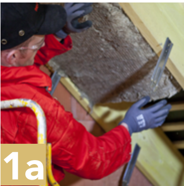
Pose de la 1 ère couche d'isolant Rockcomble Flex entre les chevrons.
