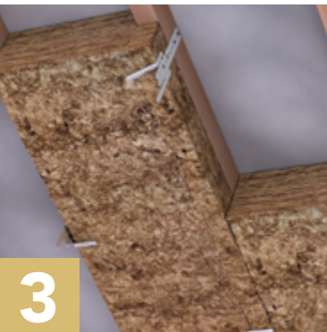
Pliage de l'ailette pour le maintien.
