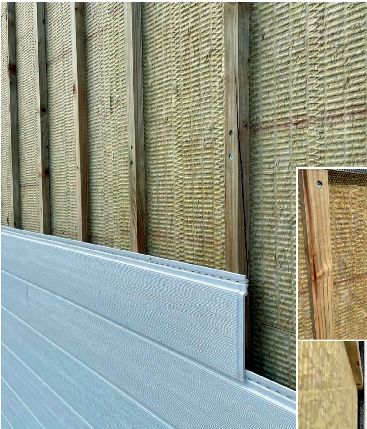
Exemple d'une pose avec ossature verticale bois
