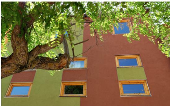
“Elegimos la lana de roca como aislamiento para las fachadas para poder aplicar el mortero directamente sobre el aislamiento y así no tener puentes térmicos porque es un aislamiento continuo, que lo hace transpirable y es compatible económicamente con el proyecto”.
