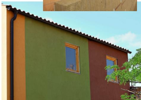
“La estructura de madera y el aislamiento exterior de lana de roca, con toda la piel del edificio continua, hace que el confort interior sea muy alto durante todo el año, además de lograr una seguridad óptima”.
