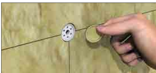
Junta en T: Se coloca una espiga en el centro de cada panel y en cada punto de contacto de junta horizontal con junta vertical
