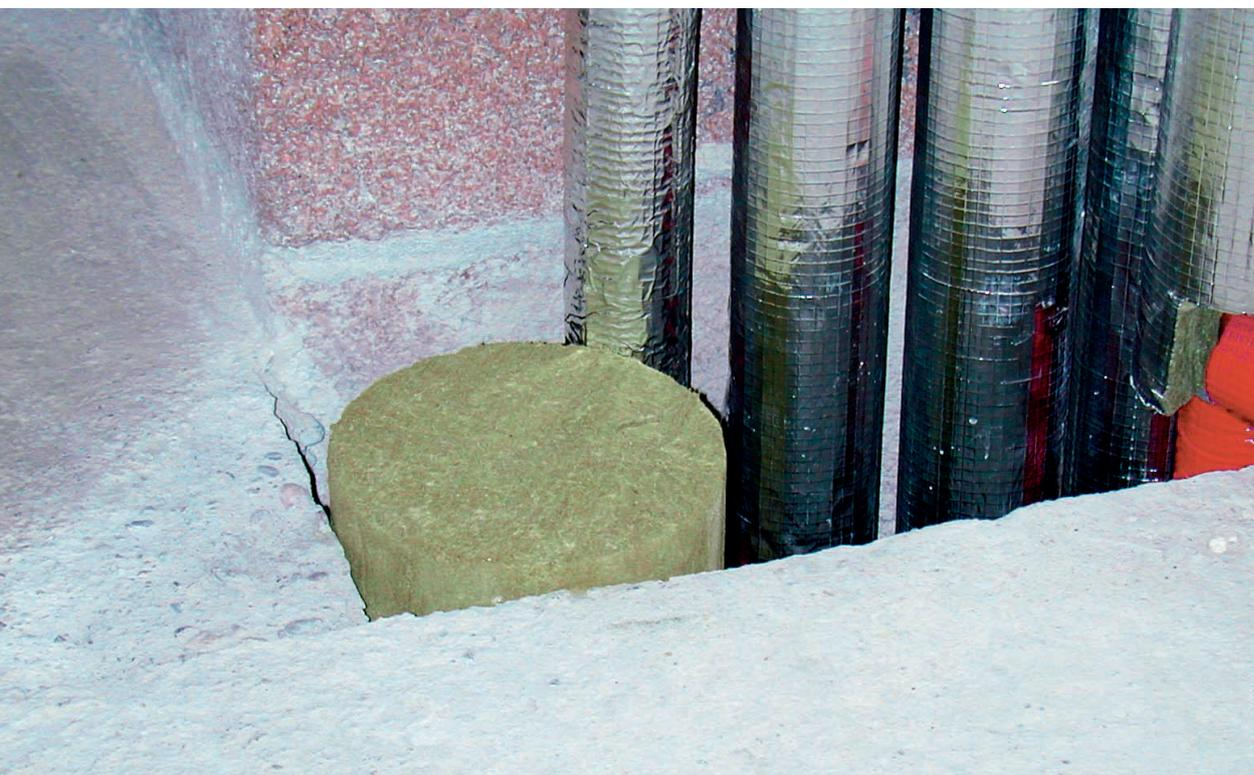
Der Conlit Fire Plug ist ein nichtbrennbares zylindrisches Steinwolle-Formteile und aufgrund seiner hohen Rohdichte besonders druckfest und formbeständig. Er entspricht im Außendurchmesser den gängigen Kernbohrungsmaßen und wird für den feuerfesten Verschluss von Kernbohrungen sowie zur Vorhaltung von Reseveabschottungen eingesetzt.
