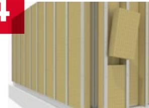
Von außen wird zwischen den Stützen die Rockzero Außendämmung angebracht. Diese Schicht legt sich nahtlos an die Kerndämmung an.\*
