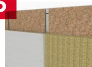
Im Anschluss daran wird die Installationsebene mit Gipsfaserplatten verkleidet.
