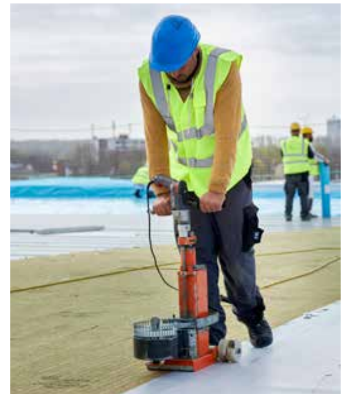
Dachaufbau mechanisch befestigt
