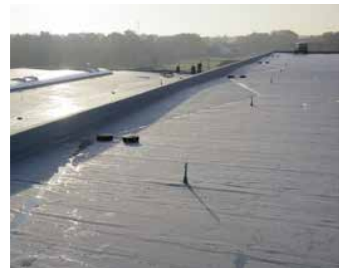
Punktentwässerung entlang der Attika
