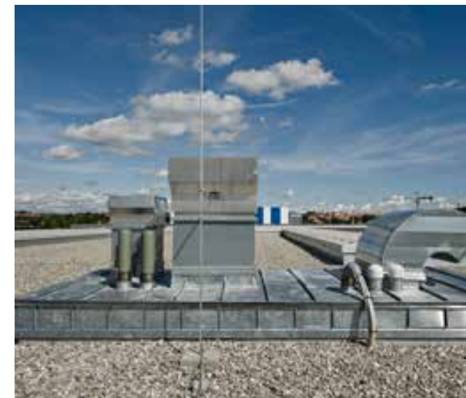
Dachaufbau lose verlegt mit Auflast
