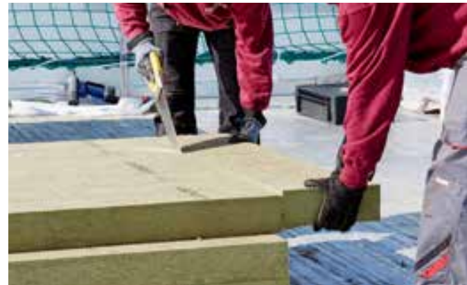
Die Dämmplatten lassen sich leicht zuschneiden.
