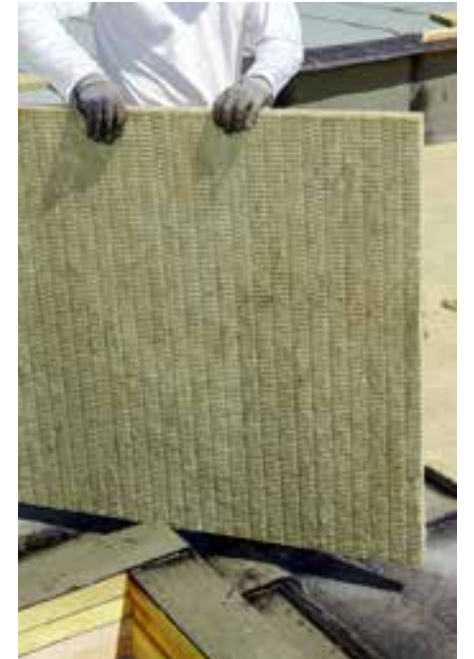
Verlegung der RP-TF auf ausgebessertem altem Dachaufbau
