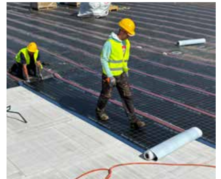
Dachaufbau verklebt
