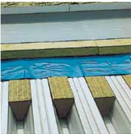
Brandschutz-Profilfüller zum Lastabtrag
