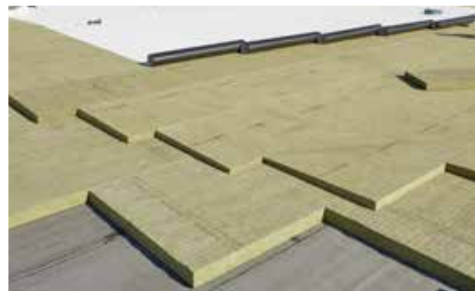
Die Verlegung der Dämmplatten erfolgt im Verband.
