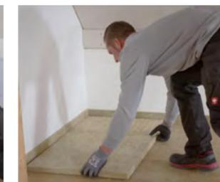
Zweilagige Verlegung durch Kombination von Floorrock Acoustic CP5 und Floorrock Therm.
