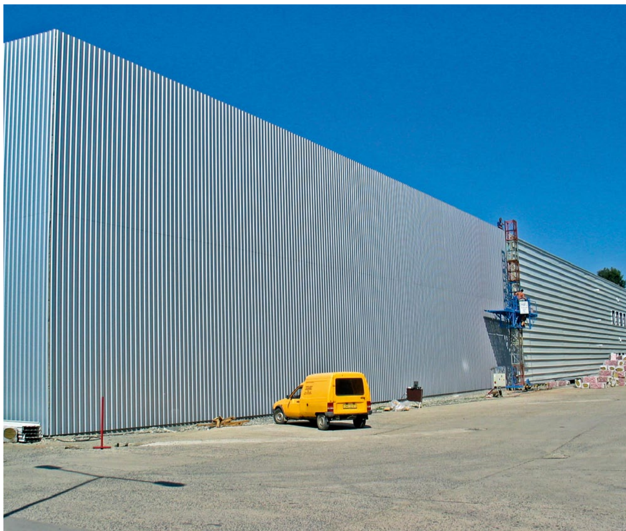
Kompletace kazetového systému ROCKPROFIL
